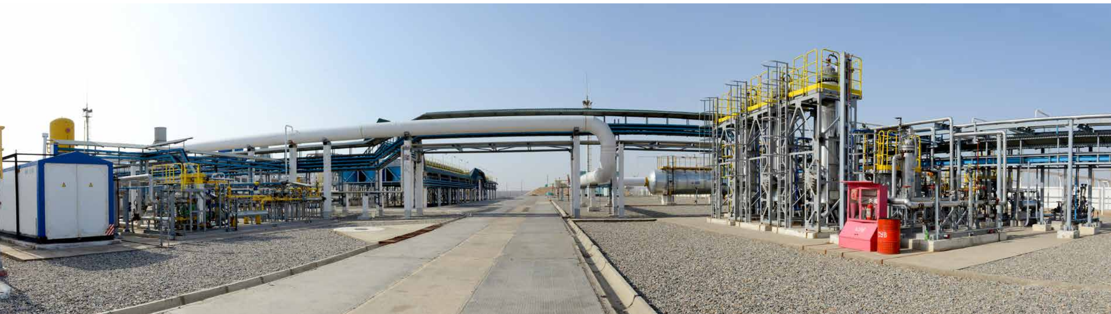
Дожимная компрессорная станция «Алан» строится в рамках обустройства одноименного газового месторождения на юге Узбекистана.
